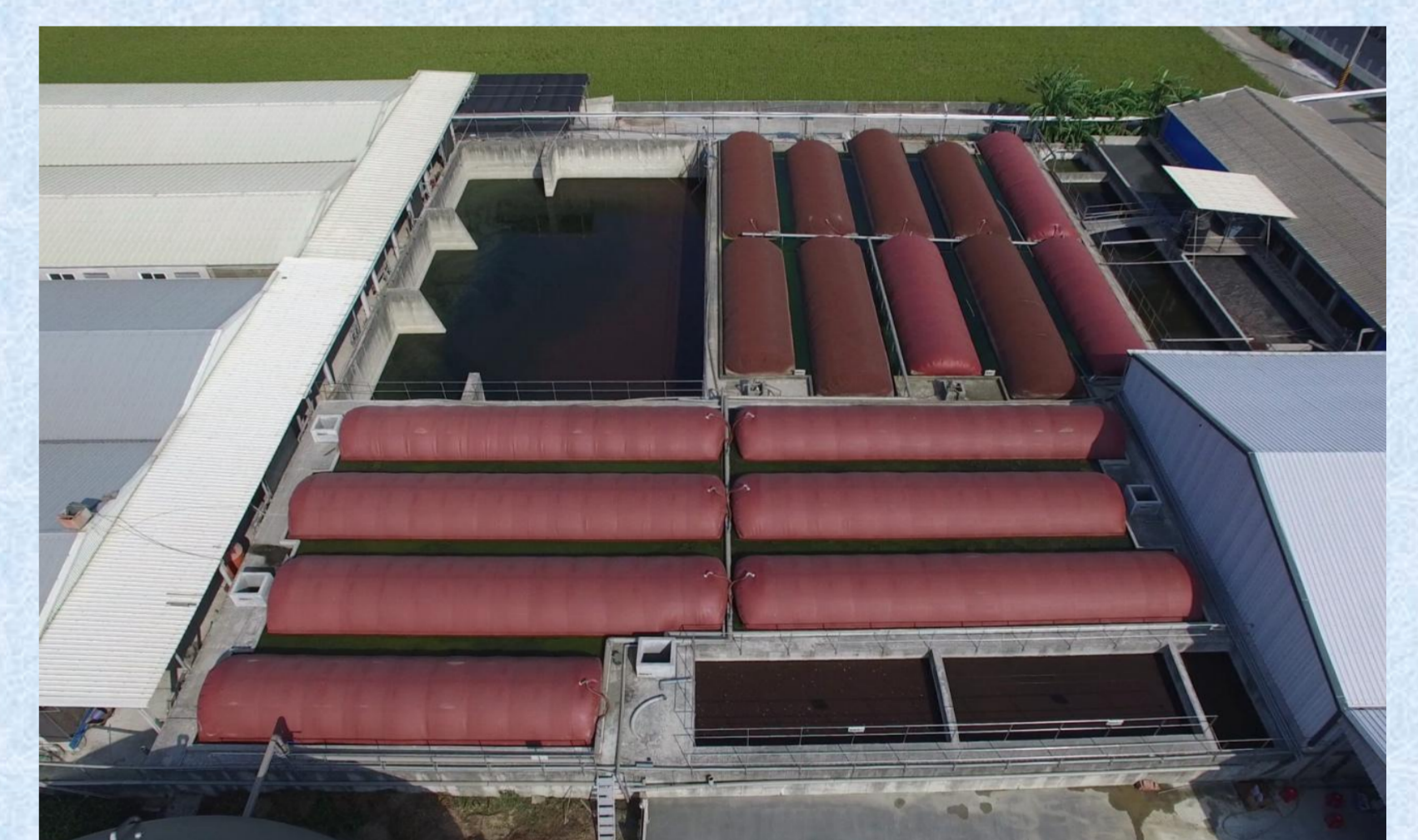
圖3. 畜牧場厭氣發酵槽。
