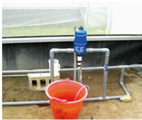
▲ 圖3. 利用定比稀釋器施用液肥，並配合分區控制閥，可有效管理肥料、水分的使用
