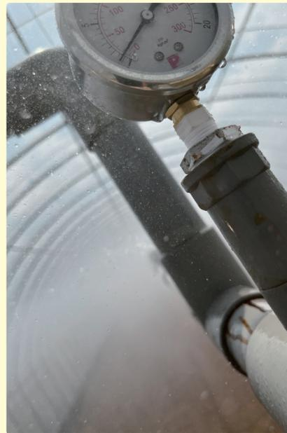
▲(a)幫浦後方及(b)溫室前方(銅質固定式噴頭可直接更換為壓力計)安裝壓力計。
