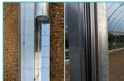
說明：高緻密度防蟲門限位槽可與多種尺寸鋸管連結
