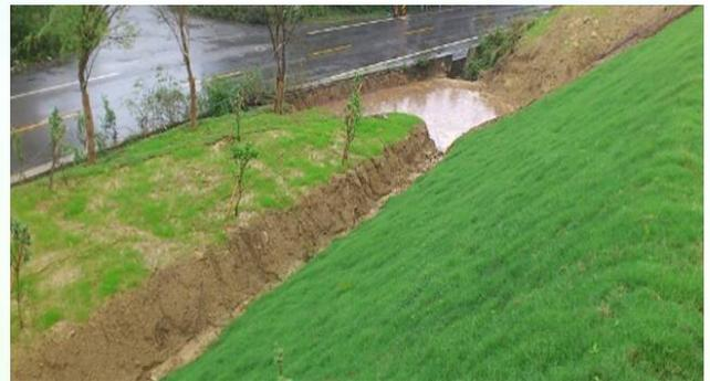
圖三、利用沉砂滯洪池防止土砂流失。
